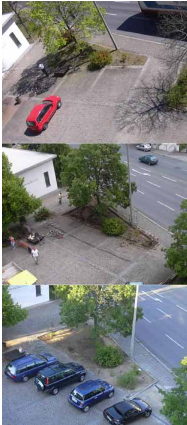
Oben: Kirchplatz in Schniegling bis 2007 Mitte: Rückbau des Pflasters am Kirchplatz 2007 Unten: Freifläche zur Regenwasserversickerung
