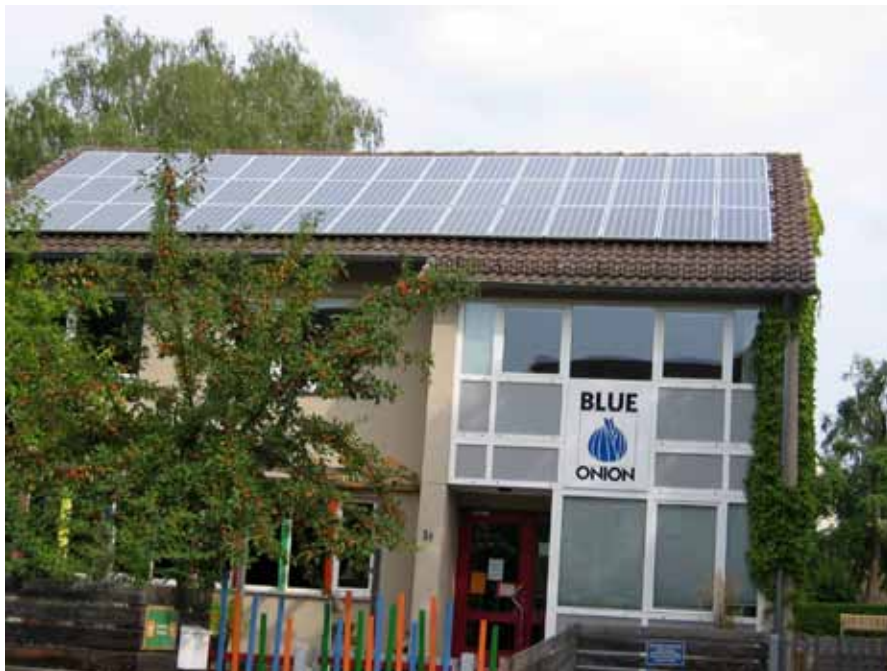
Photovoltaik-Anlage auf dem evangelischen Kindergarten Bad Neustadt
