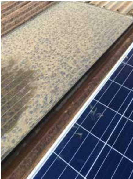
Eine dicke Staubschicht schmälert den Ertrag des Moduls erheblich © Hans Köhler
