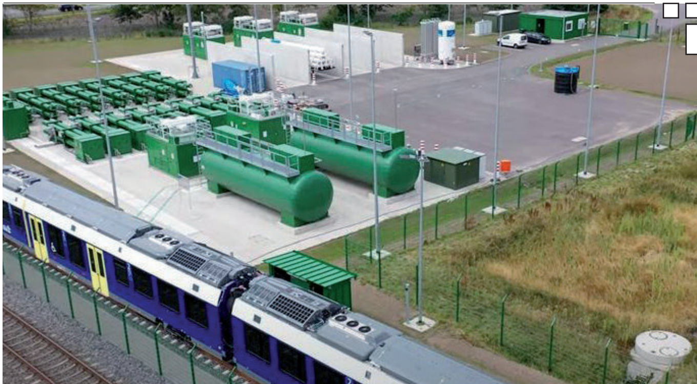
Zugtankstelle in Bremervörde, Niedersachsen
