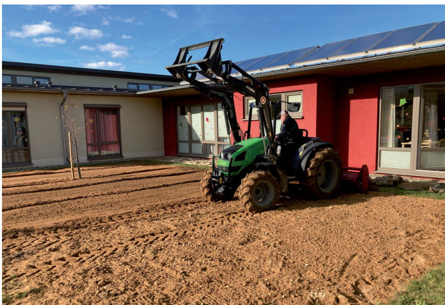
Die Grasnarbe wird abgetragen und der Boden gesandet und gefräst
